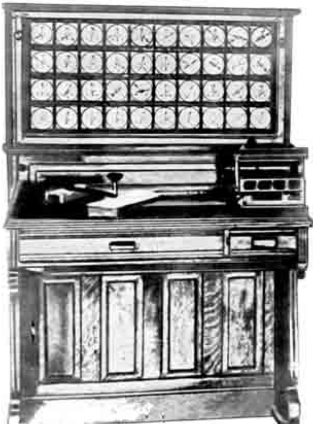
Рис. 1.14. Електромеханічний табулятор Холлеріта
